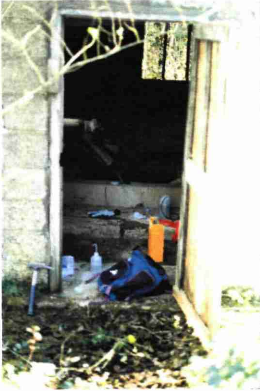
Fiche n°1: bâtiment de la parcelle 18 abritant un puits
