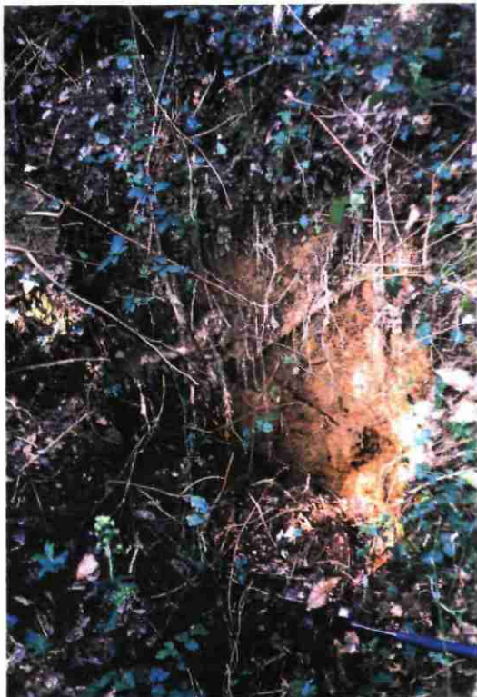
Fiche n°6: Vue de l'effondrement récent
