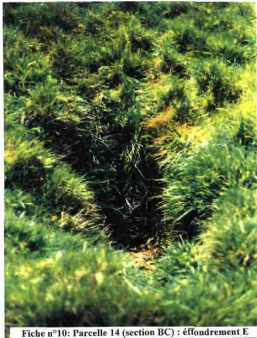
Fiche n°10: Parcelle 14 (section BC) : éffondrement E
