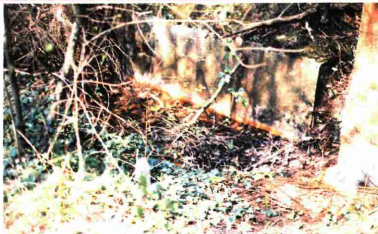
Fiche n°7: Réservoir coté sud de la laverie allemande
