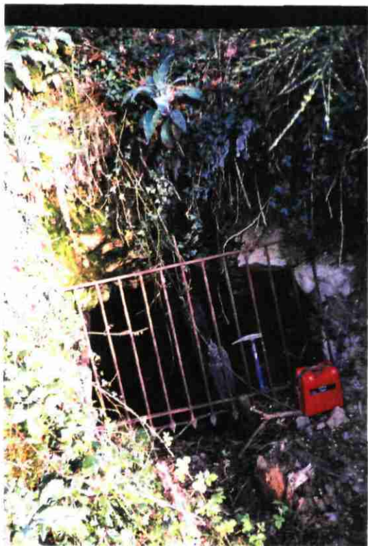
Fiche n°1 : Entrée de la galerie -40 m Eau dans le fond
